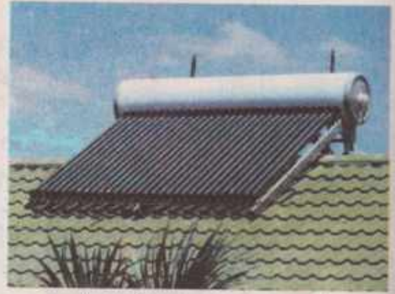
شکل 5.15 چھت پر لگائے گئے سولر وٹنلر
